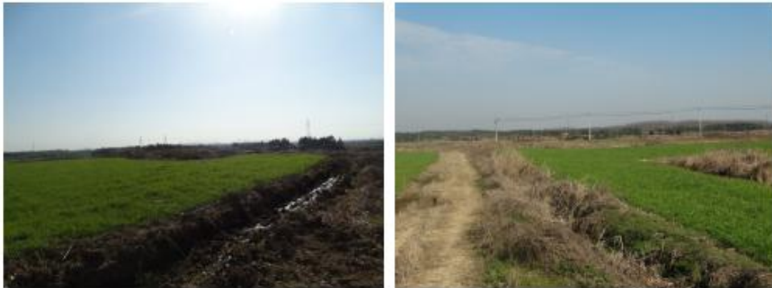
图 1.2-2 厂址原有排水沟渠
