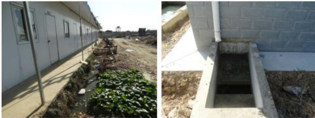
员工宿舍临时排水沟
