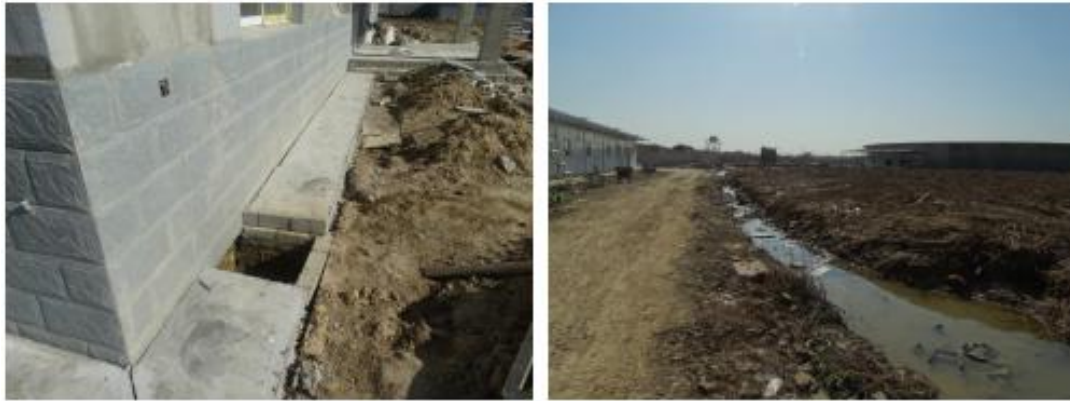
建筑物排水管接口
